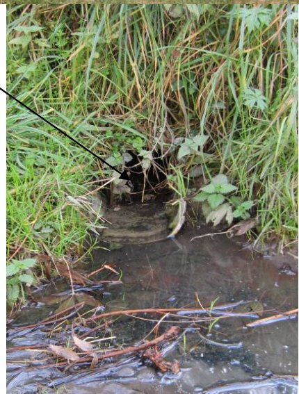
Canalisation de sortie DN200
