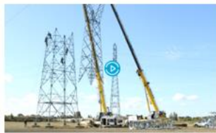
Vidéos sur les étapes d'un chantier de construction d'une ligne aérienne et d'une liaison souterraine
