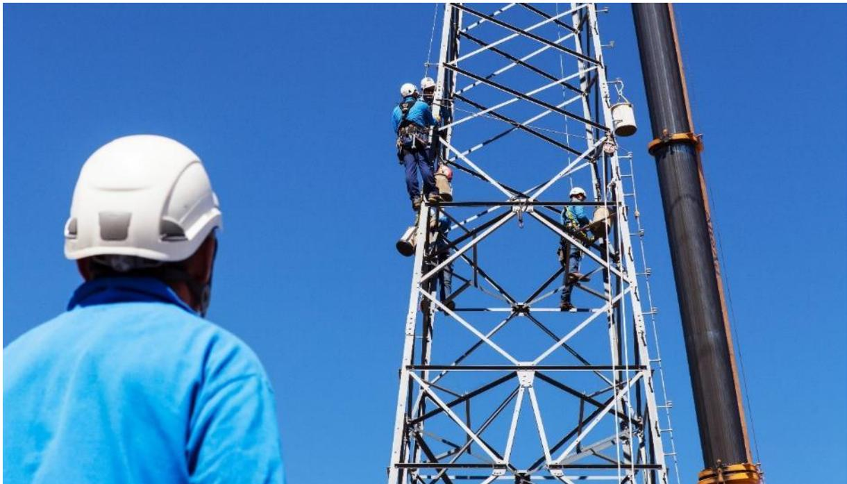
**Assemblage pour remplacement d'un pylône afin d'augmenter les capacités d'une liaison par exemple**
