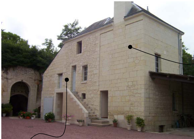
Partie de façade traitée en moellons de tuffeau assisés.
