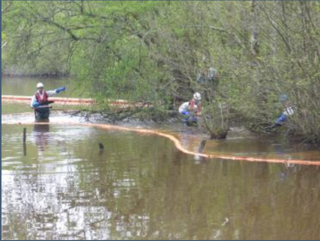
Concentration du polluant résiduel à l'aide de soufflantes en zone d'accès difficile
