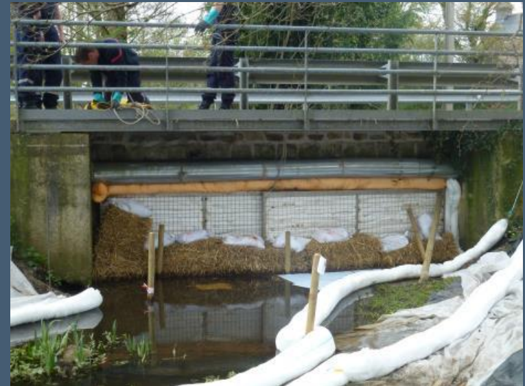
Caissons de filtration paille et absorbant
