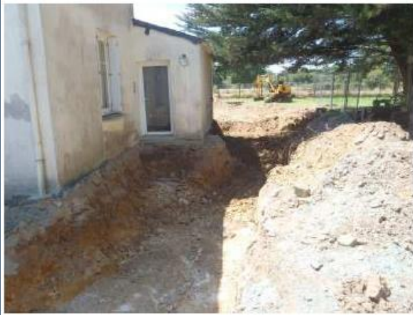
Excavation des sols impactés
