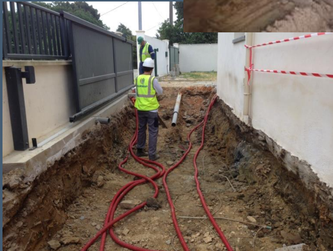
Remplacement des réseaux enterrés
