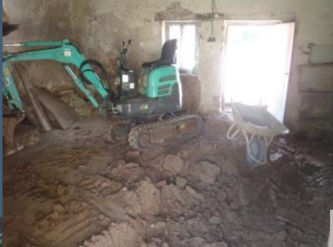
Excavation des sols impactés
