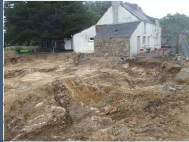
Excavation des sols impactés
