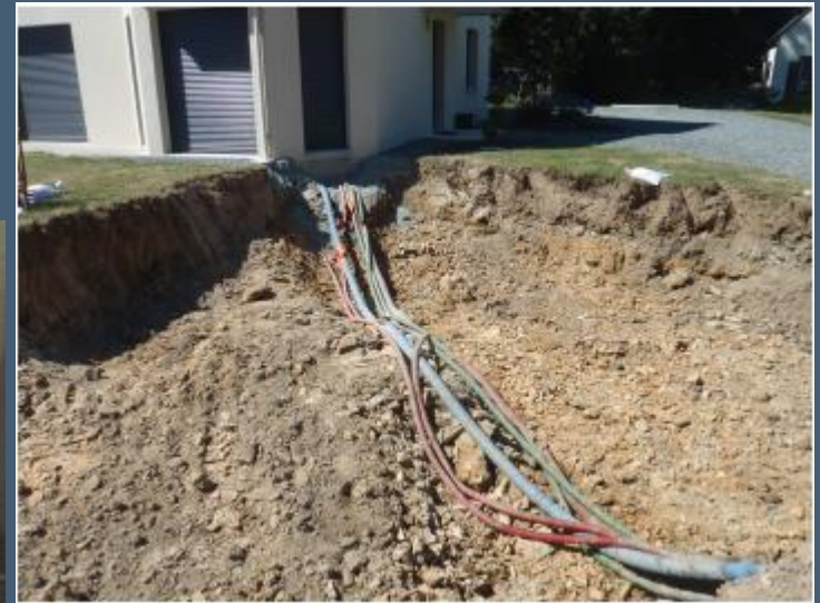
Remplacement des réseaux enterrés
