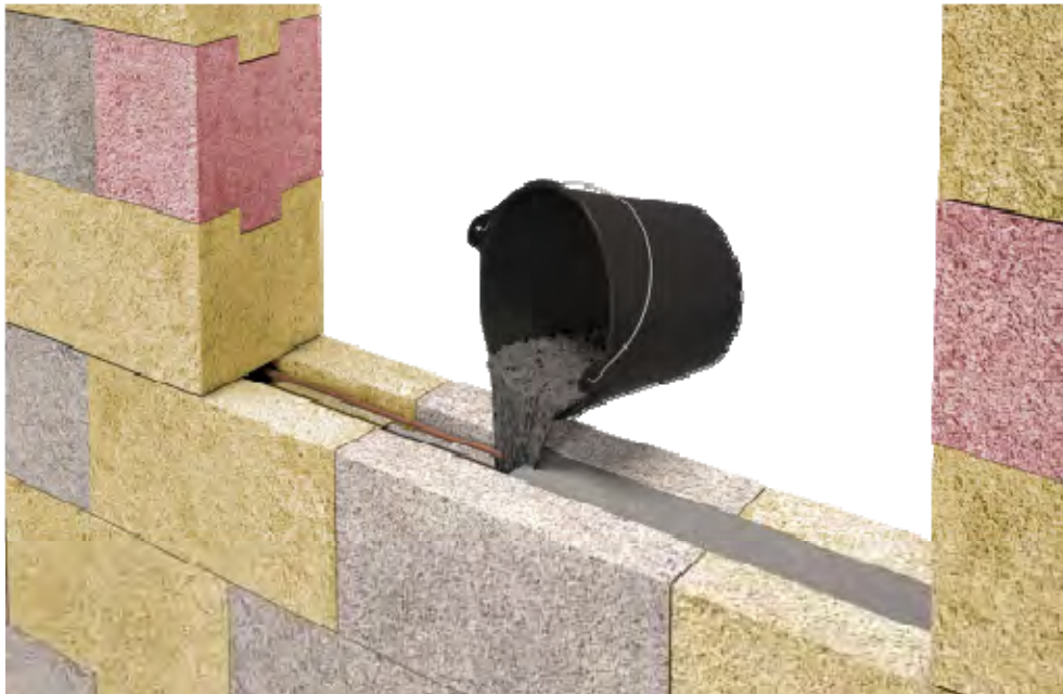
Figure 43 : coulage du béton dans l'appui de fenêtre
