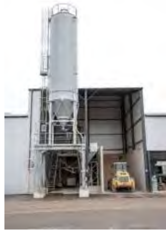
Figure 18 : trémie de stockage de la chènevotte et silo de stockage du Ciment Naturel Prompt
