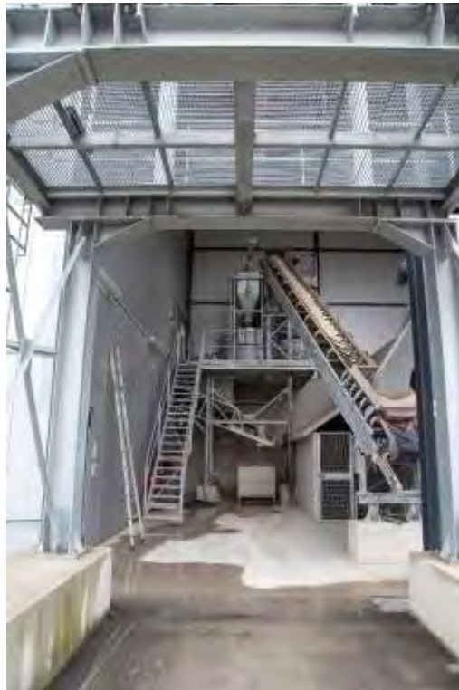
Figure 19 : centrale à béton de chanvre
