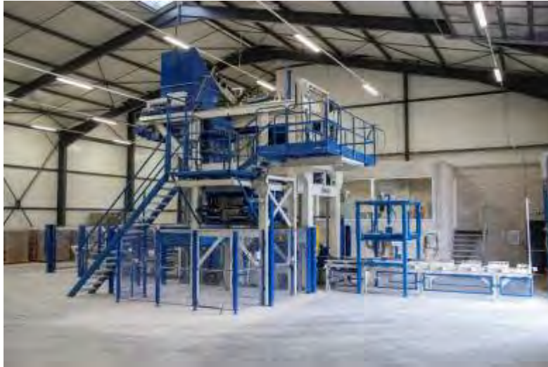
Figure 22 : vue d'ensemble de la presse et de la cabine de conduite
