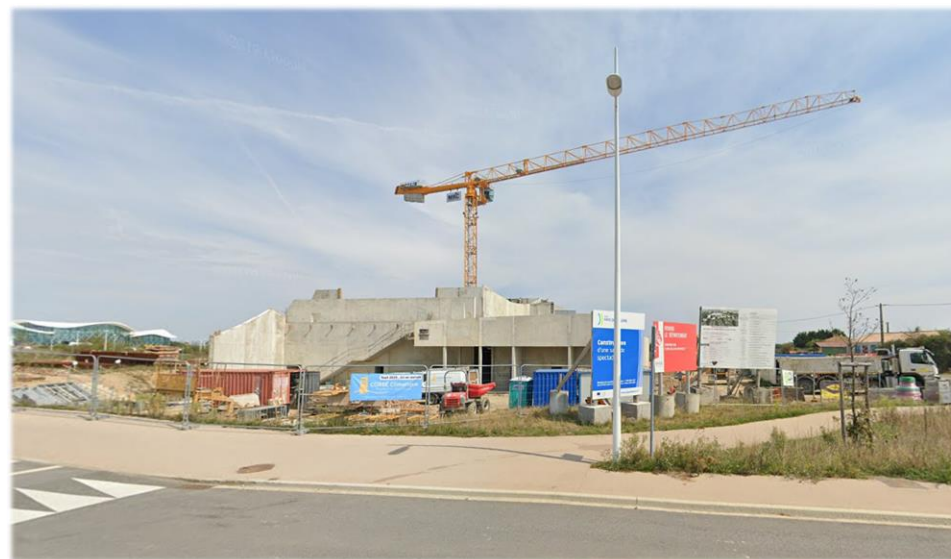
⑧ (salle de spectacle « La Balise » en construction – Août 2019)
