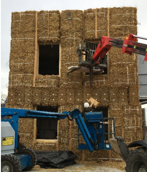
Façade Paille et Menuiserie à Ossature bois
