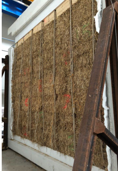
Mur porteur en paille
