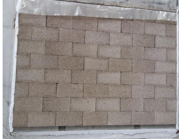
Mur en blocs en béton de chanvre
