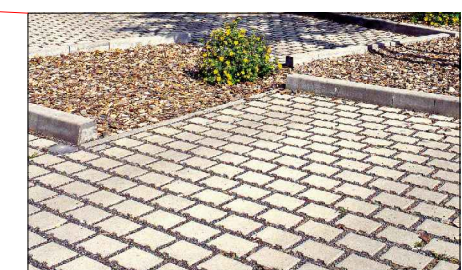
EXEMPLE DE STATIONNEMENT EN PAVÉS D'INFILTRATION
