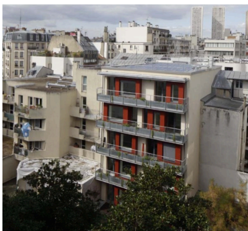
2012 - Logements collectif Paris
