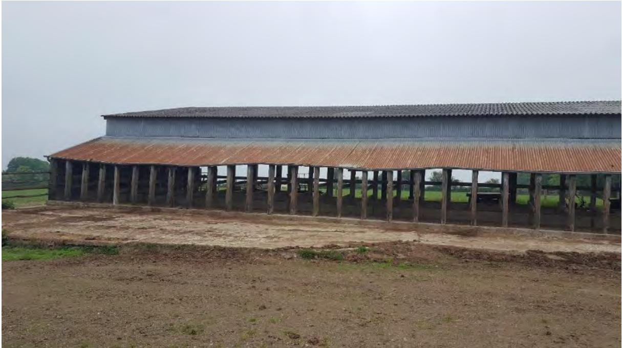
Photo 8 / Bâtiment inutilisé présent sur la parcelle sud-ouest à Torcé (photo prise le 24 avril)
