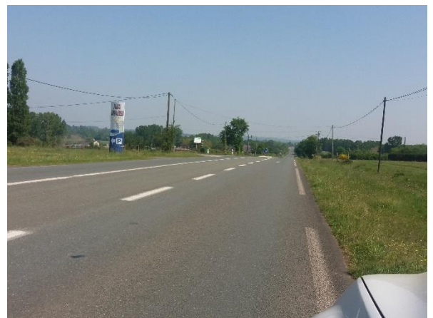
Prise de vue en aval du point 48
