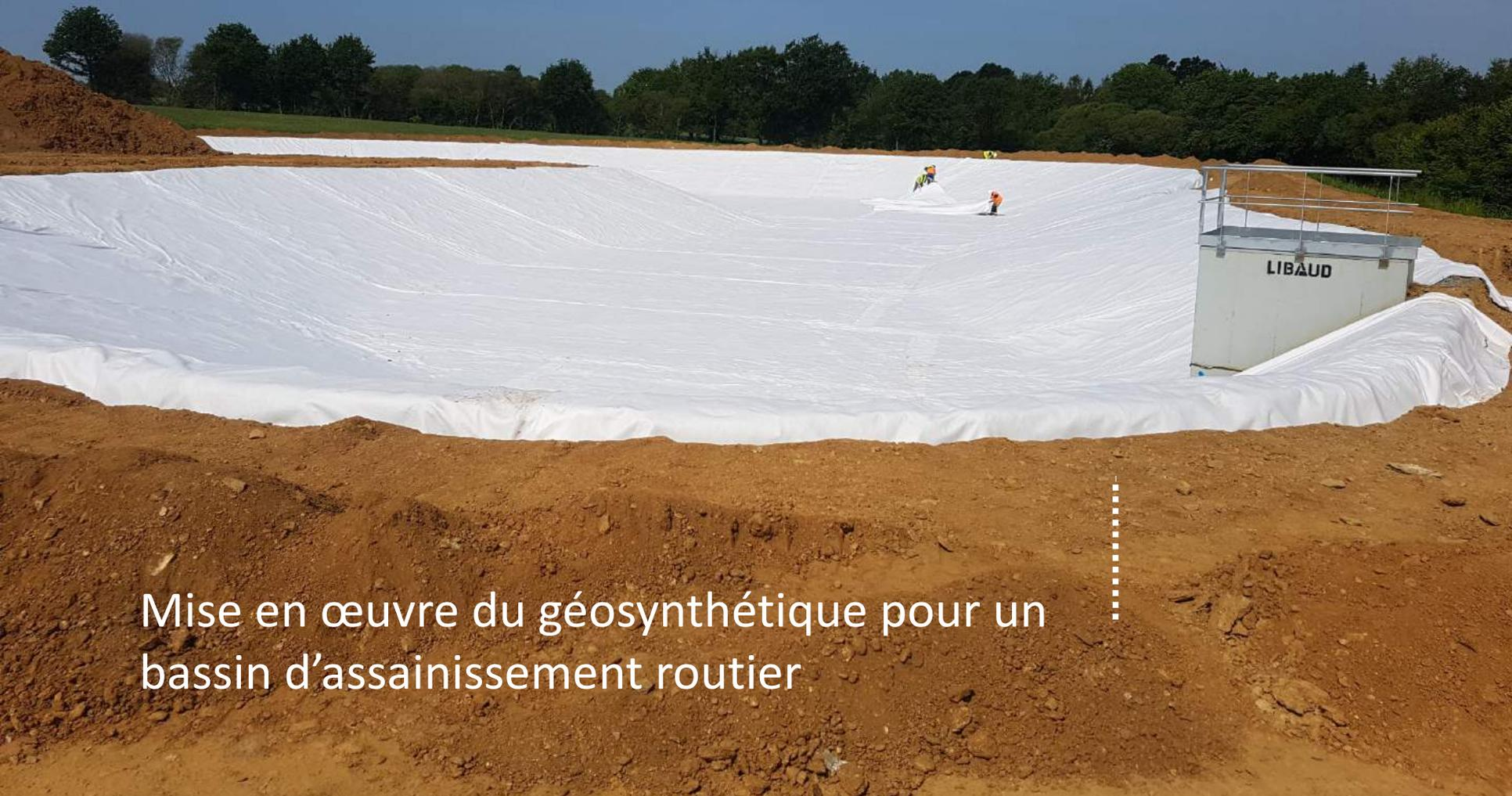
Mise en œuvre du géosynthétique pour un bassin d'assainissement routier
