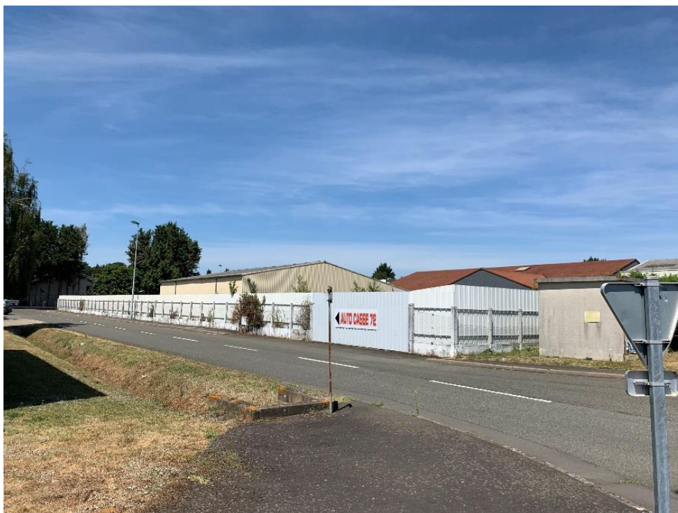
Photographie 8 : Vue de l'angle sud-est du site depuis le carrefour entre l'allée de la Coudre et le Boulevard des Ravalières
