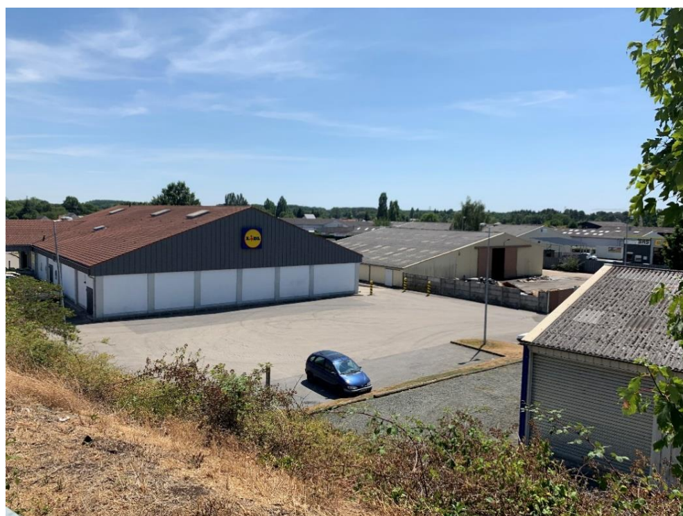
Photographie 12 : Insertion du projet – vue lointaine depuis la route du Tertre
