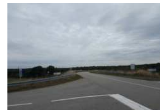
Franchissement RD775 par RD181
