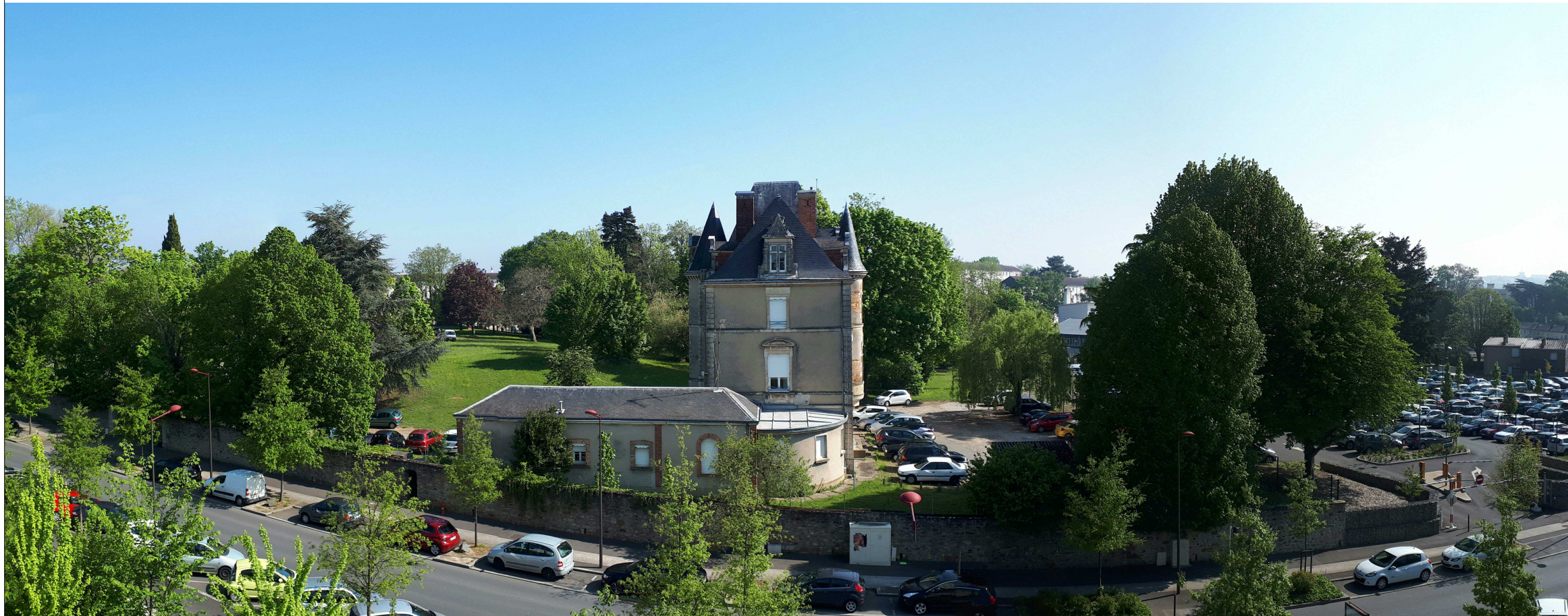
P1 : Environnement lointain (30/04/2019)
