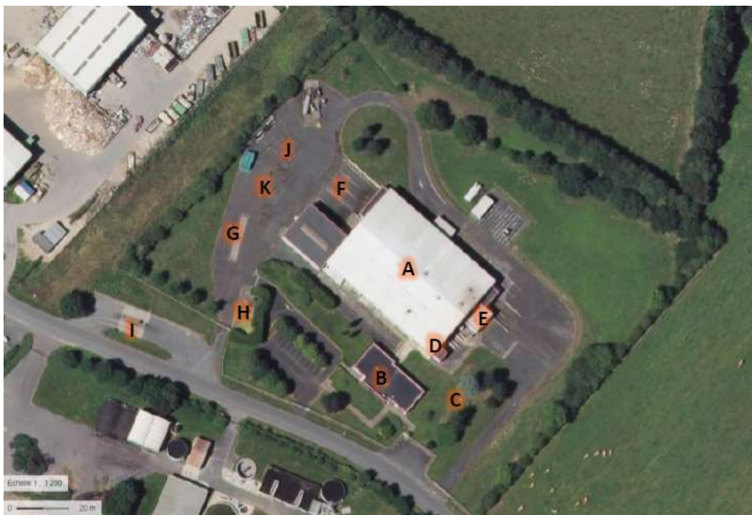
Vue aérienne de la parcelle d'implantation du projet, des bâtiments et installations de l'activité antérieure – source dossier
