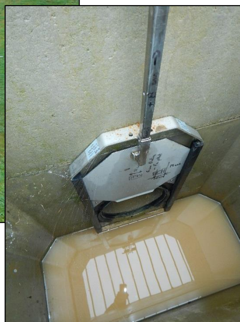
Photo 1 : Vue du bassin d'orage et de l'ouvrage de sortie (vanne manuelle)
