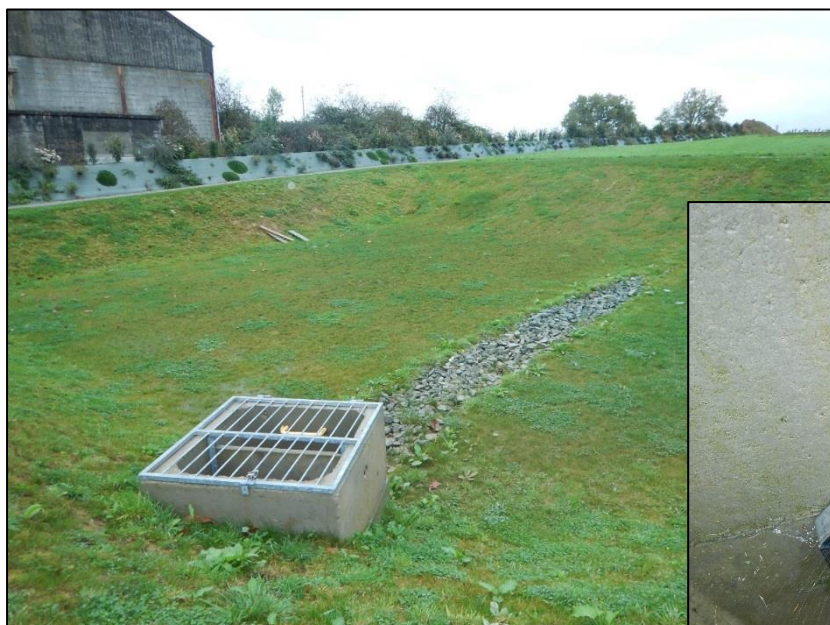
Photo 1 : Vue du bassin d'orage et de l'ouvrage de sortie (vanne manuelle)
