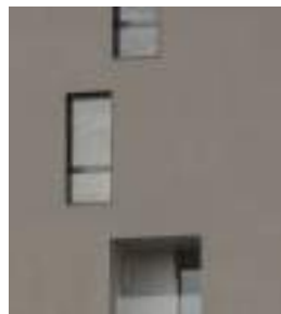
FACADE BETON FINITION LASURE GRIS FONCE
