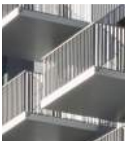
SOUS-FACE ALUMINIUM BALCON EN SAILLIS
