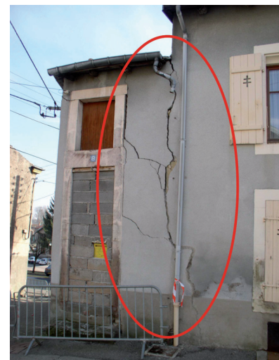
Séisme de Baccarat, exemples de dommages causés sur le bâti : destruction de cheminées et lézardes entre un bâtiment et son annexe. © BRGM
