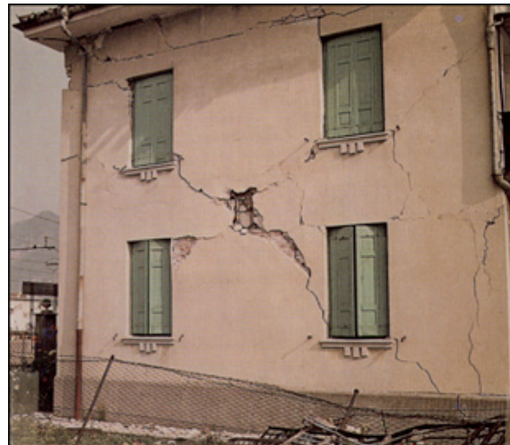
Exemple de lézardes causées par un séisme (Annecy, 1996). © BRGM
