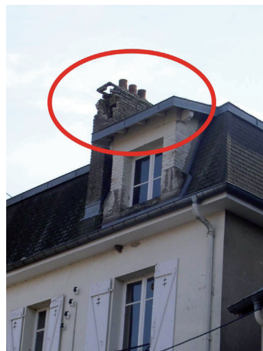
Séisme de Baccarat, exemples de dommages causés sur le bâti : destruction de cheminées et lézardes entre un bâtiment et son annexe. © BRGM
