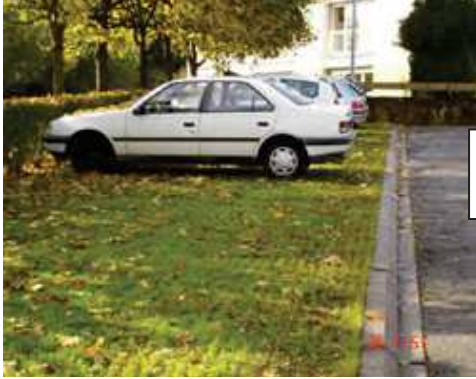
Parking engazonné perméable
