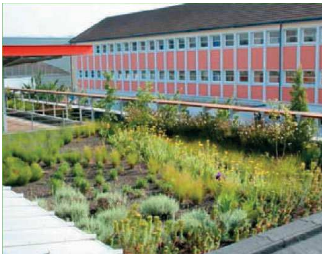
Toiture stockante végétalisée
