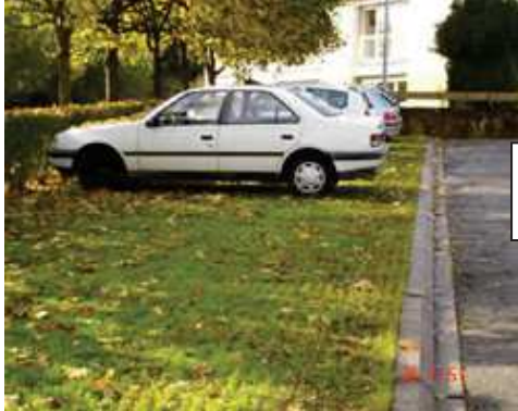
Parking engazonné perméable
