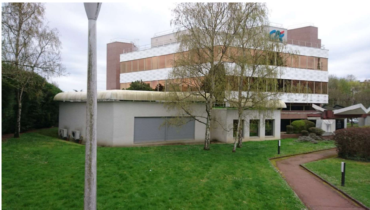
Photographie de l'ancien siège social du crédit Agricole (façade nord)
