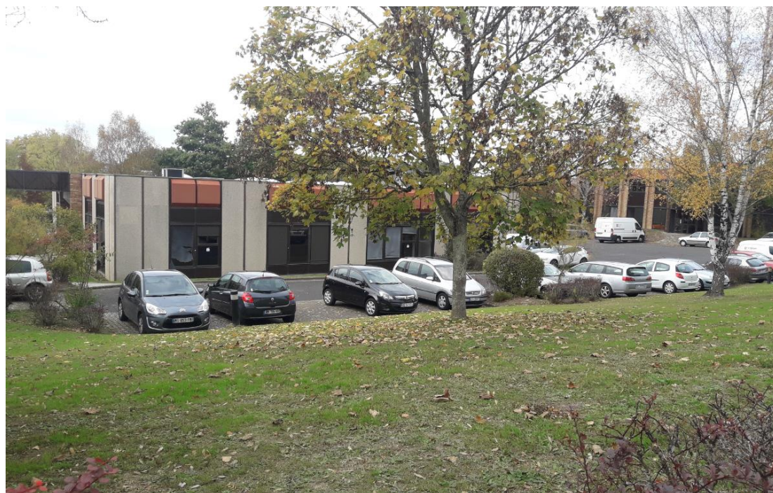
Photographie 4 : Vue du site depuis la route de Saint-Joseph – vers le Nord-Ouest (BURGEAP, novembre 2018)
