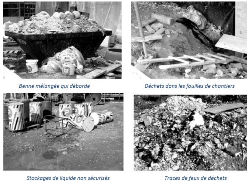
Figure 50 : Exemples de gestions non appropriées des déchets de chantiers
