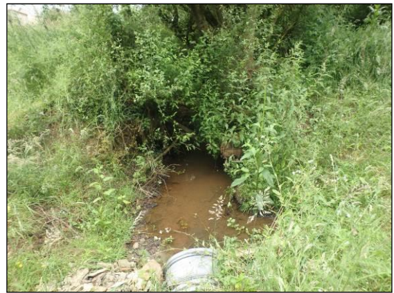
Le "ruisseau de la Rivière", en limite sud-est
