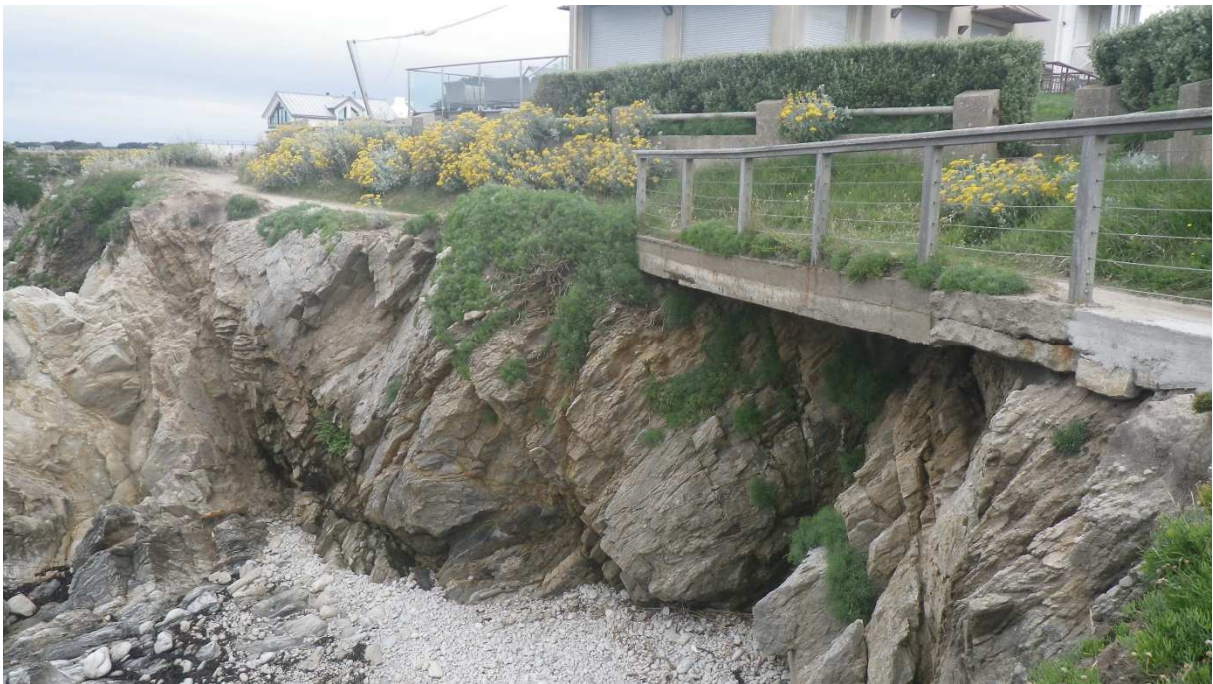
Vue Est (2) en date du 14/06/2018.
