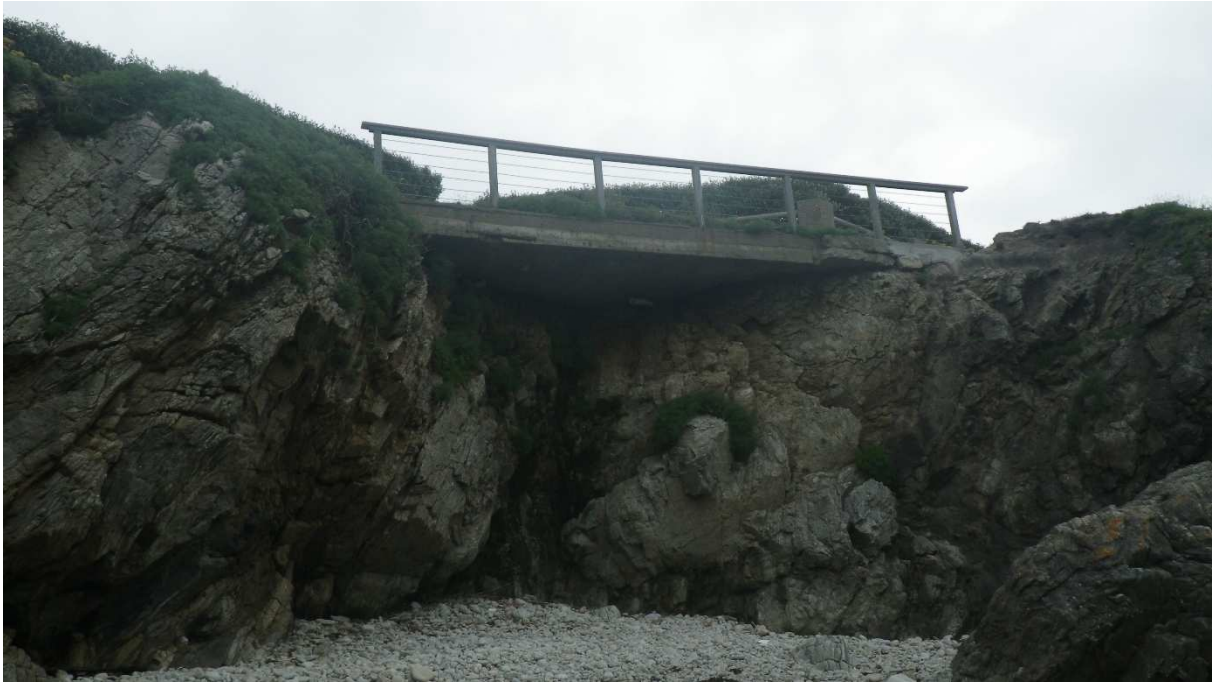
Vue de face (1) en date du 14/06/2018.
