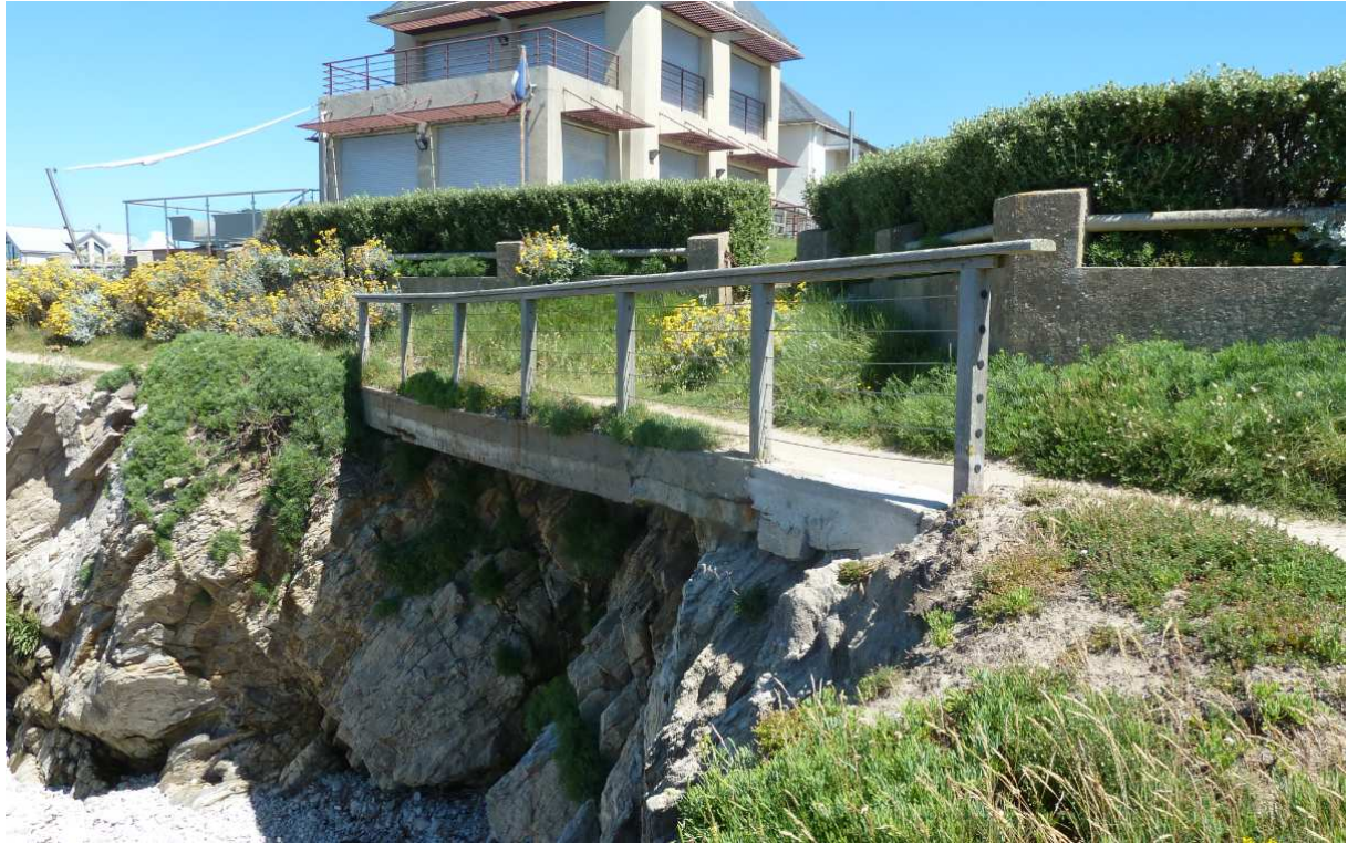
Vue générale de la passerelle : massif de cinéraire, chiendent, et Criste marine. (Photo prise le 22/06/2018).
