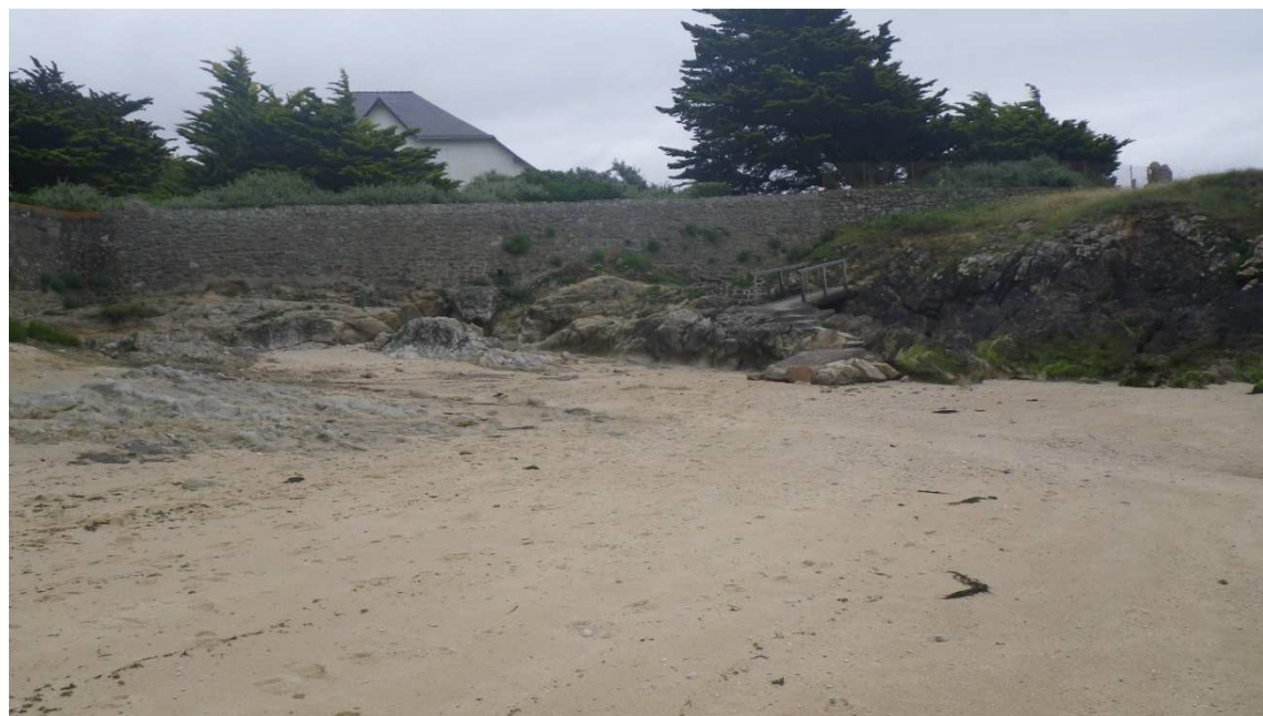
Vue générale du projet (1) en date du 14/06/2018.
