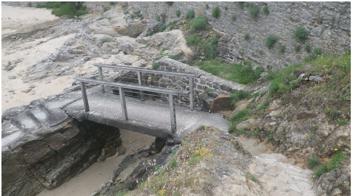
Vue de l'Ouest du projet (3) en date du 14/06/2018.
