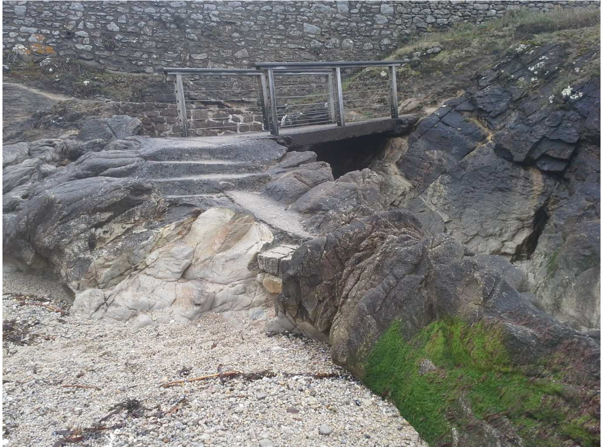
Vue de l'Est du projet (2) en date du 10/04/2018.
