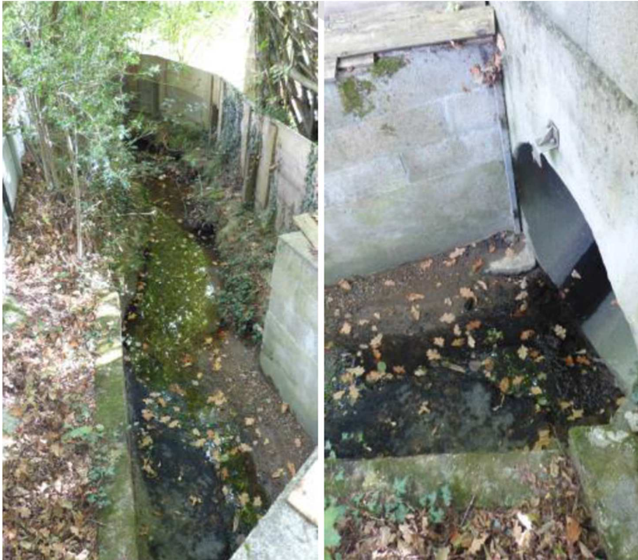
Ruisseau en aval du tronçon canalisé (Ø1000)
