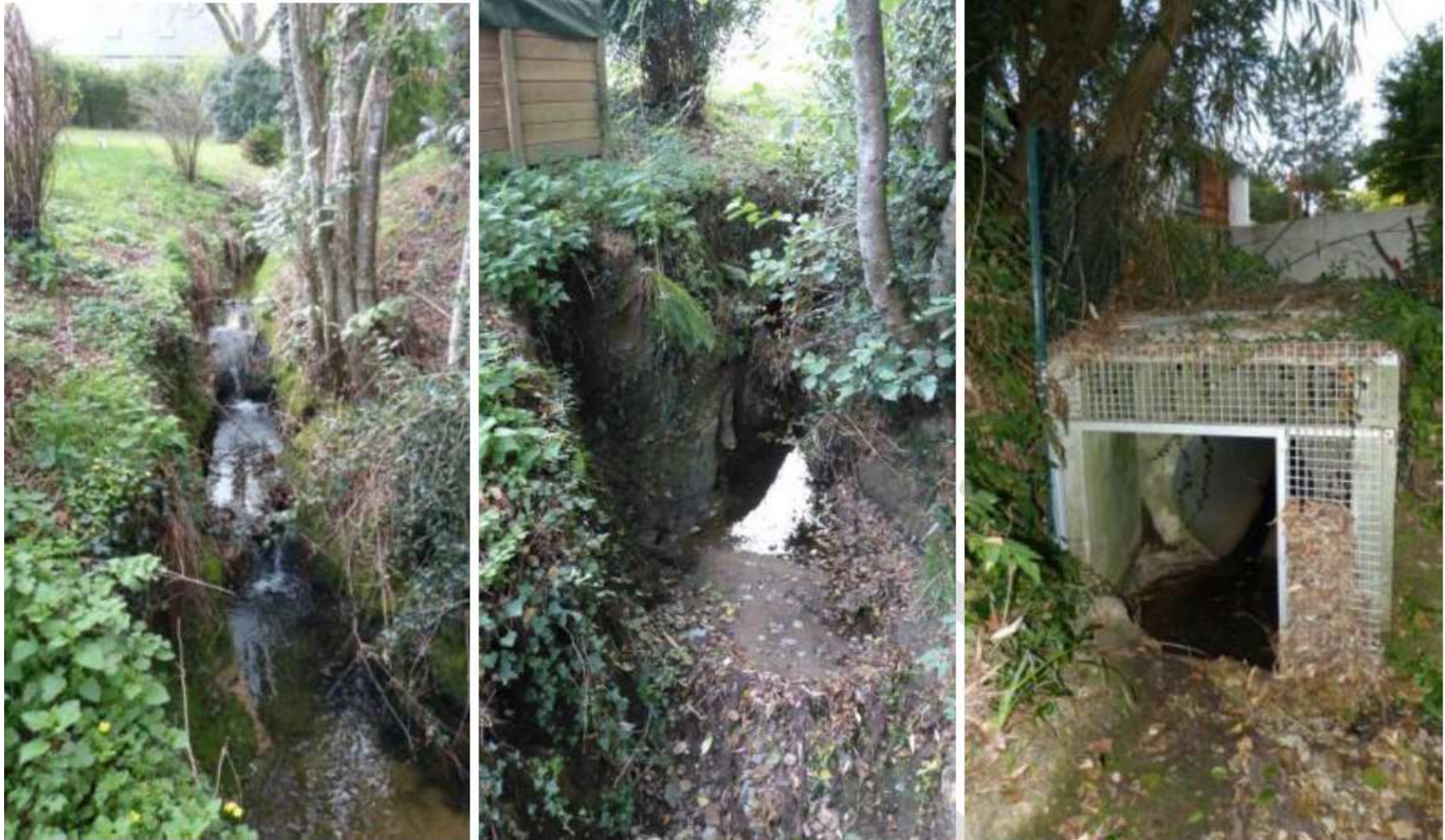
Ruisseau en amont du tronçon canalisé (Ø1000)
