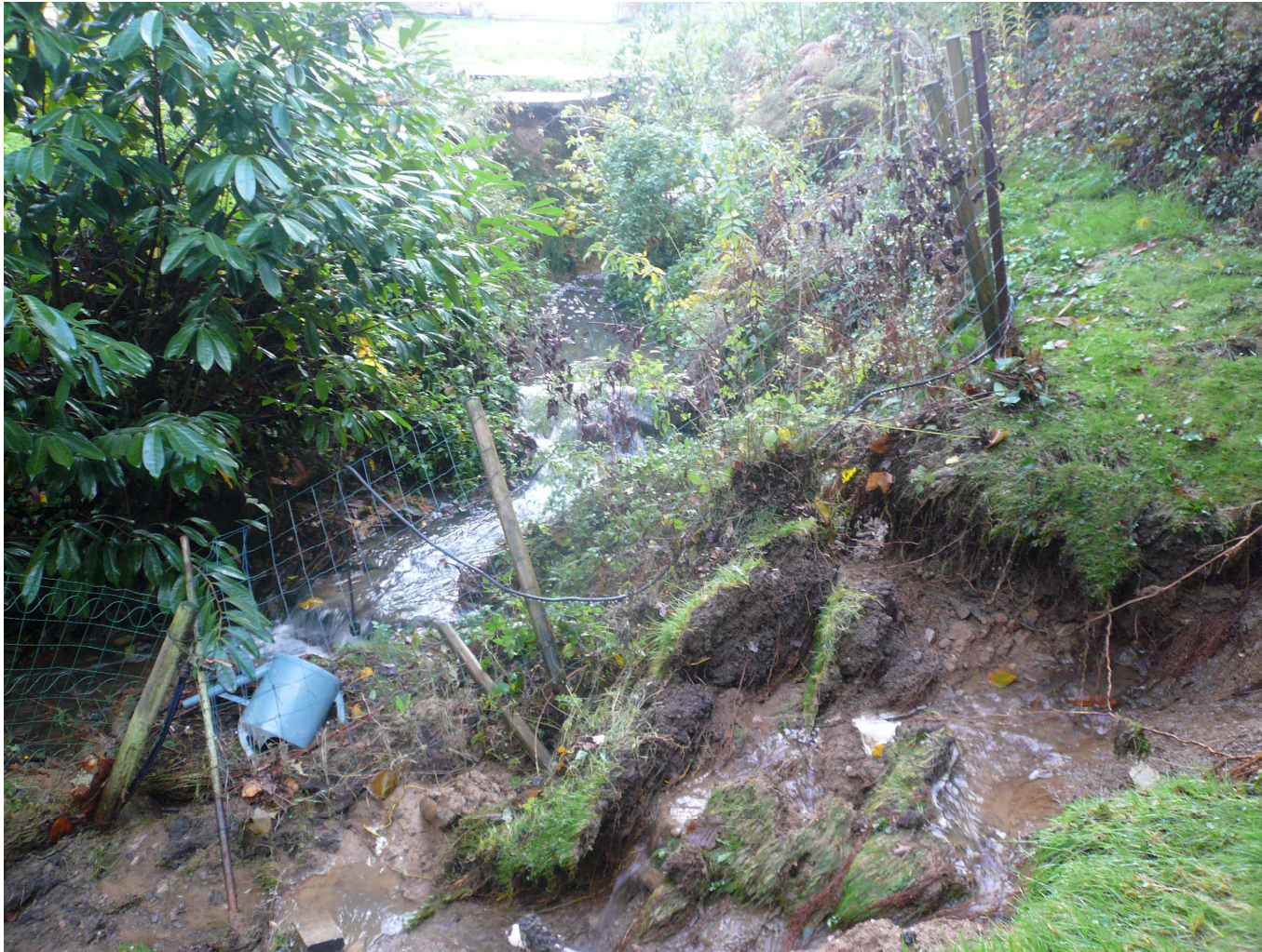
Erosion parcelle n° AR143
