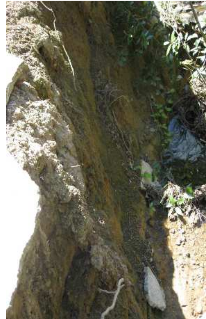
Erosion parcelle n° AR139
