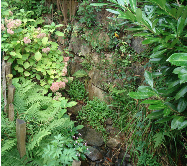
Enrochement des berges à l'amont, rive gauche
