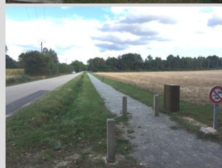
Exemple réalisé en 2016 à Saint-Marcel
