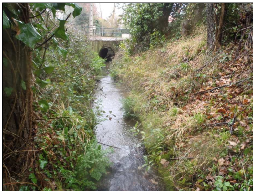
Photo 6 : Vue du busage Ø1000mm en aval du projet
