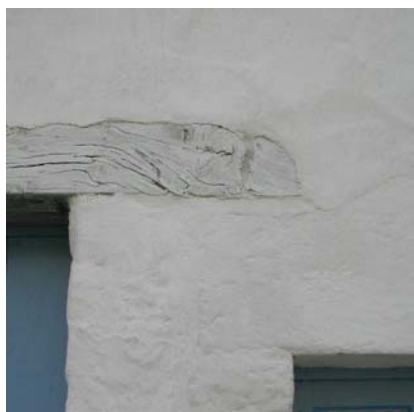
Façade entièrement badigeonnée
