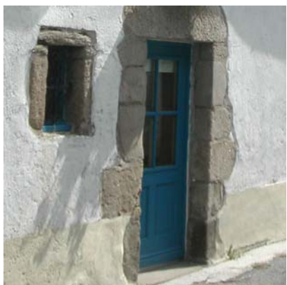
Enduit avec badigeon de chaux
