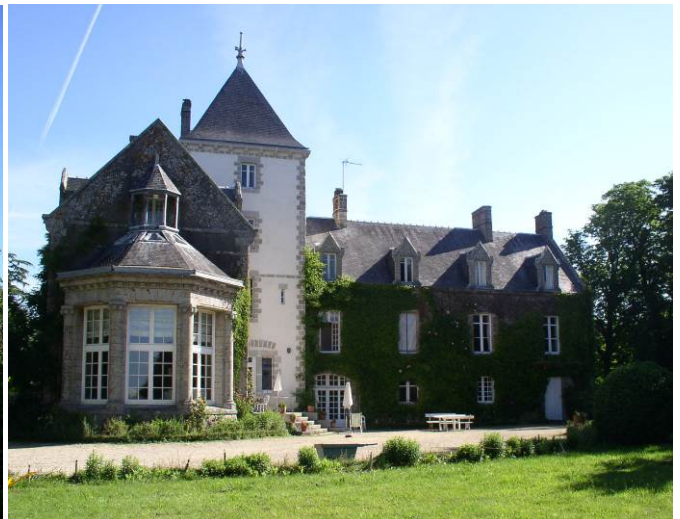
Manoir de Tesson – Façade Sud
