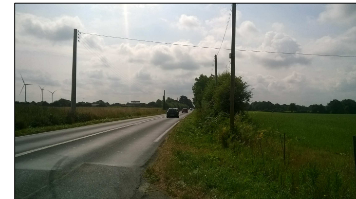
Photo 6 : route départementale n°948
