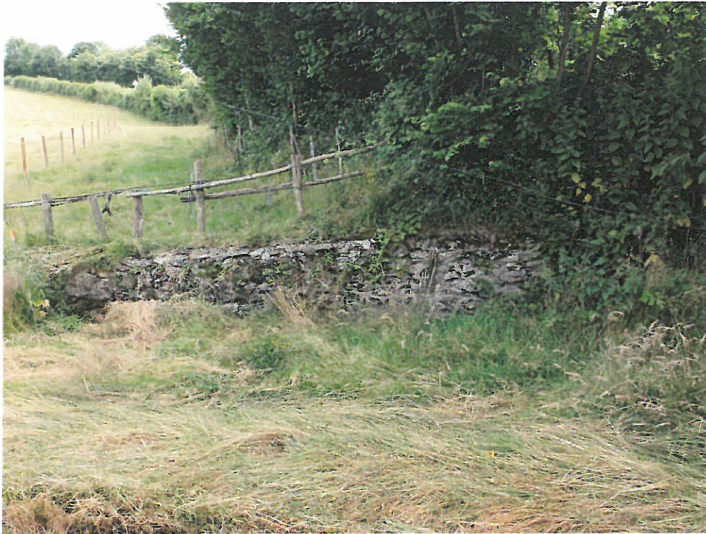
Figure 3 : Le muret à la sortie aval de l'aqueduc
