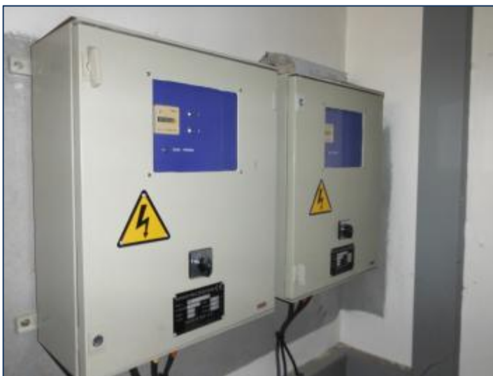
Vue des armoires électriques du traitement UV :
