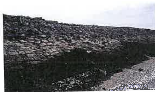
Figure 5 : Erosion et départ de moellons (secteur 1)
