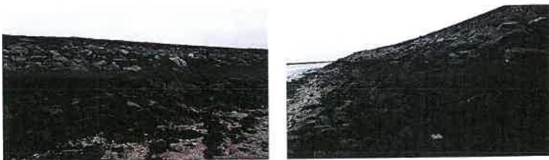
Figure 10 : Reprises du couronnement côté mer
