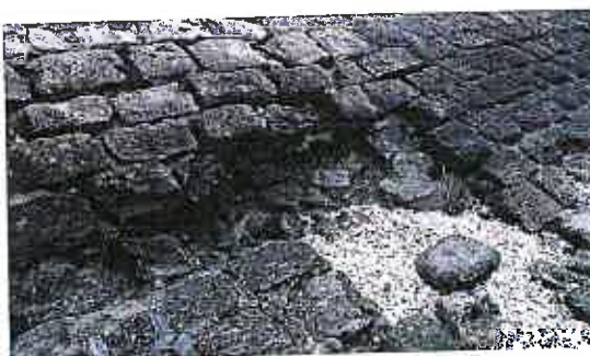
Figure 5 : Erosion et départ de moellons (secteur 1)
