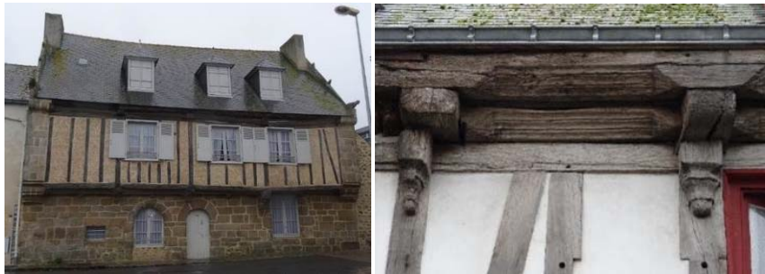
Façade à mur gouttereau en pan de bois avec encorbellement ; Détail d'encorbellement avec sablière et entretoise moulurée et pigeôtres
