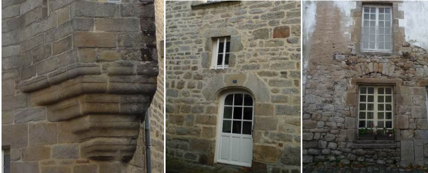
Façade à tourelle en pierres de taille ; Maçonnerie enduite à pierres vues ; Maçonnerie en moellons destinée à recevoir un enduit couvrant
