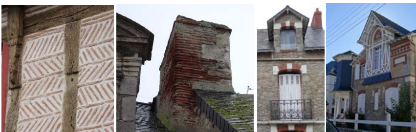
Remplissage de pan de bois et souche de cheminée en briquettes traditionnelles ; brique industrielle utilisée en décors
