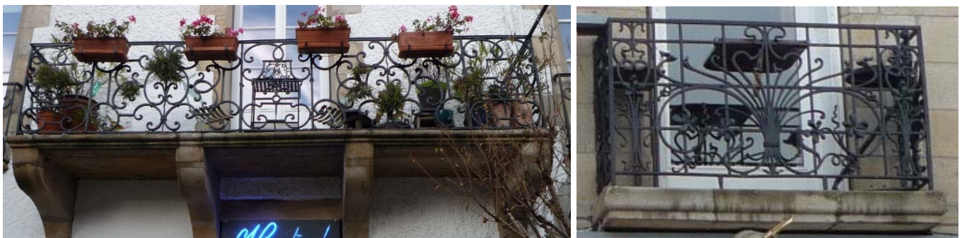
Balcon avec ferronnerie du XVIII e siècle (hôtel de Limur) ; garde-corps en fonte moulé d'esprit Art-Nouveau
