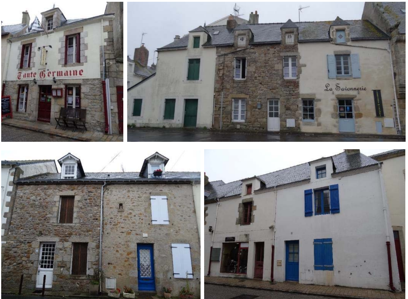
Maison de ville à composition axiale et symétrique (1848) ; maisons en série place de Dinan (1834), rue Hervé Rielle, rue de l'Eglise.
