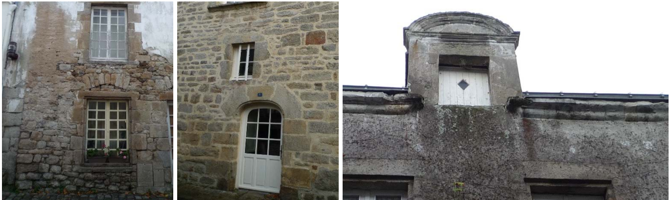
Maçonnerie en moellons destinée à recevoir un enduit ; maçonnerie en moellons équarris ; corniche et lucarne en tuffeau
