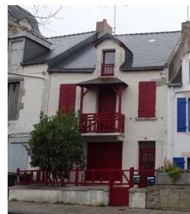
Maison de ville du XVII e siècle remaniée au début du XX e siècle (perçement des travées latérales, ajout d'un balcon et d'une
