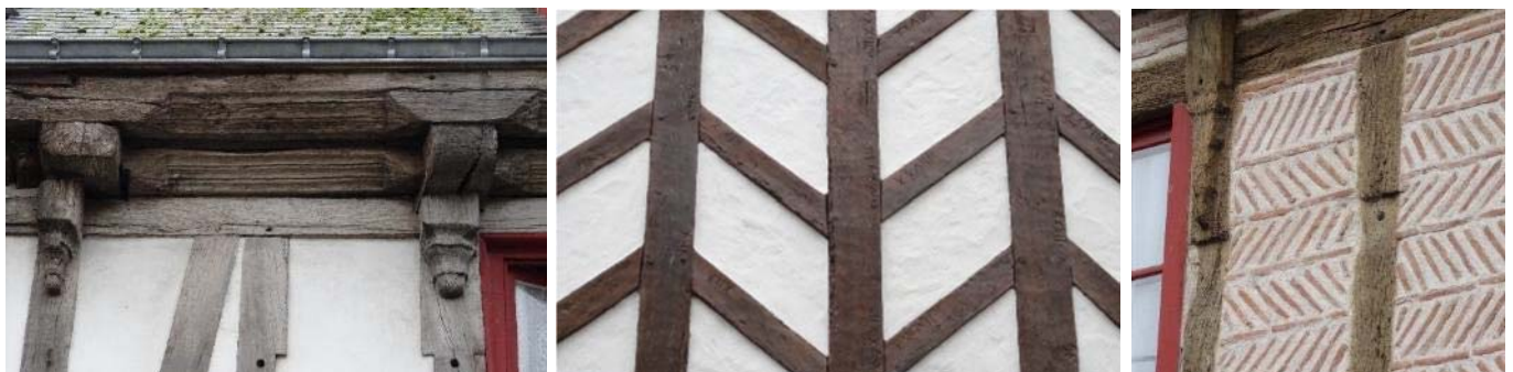
Détail de sablière et entretoise moulurées avec pigeâtres sculptés. Maison Guillaume André (vers 1558) détail des éléments disposés en fougère et numérotés pour en faciliter l'assemblage. Détail du remplissage en briques disposées en arêtes de poisson.
