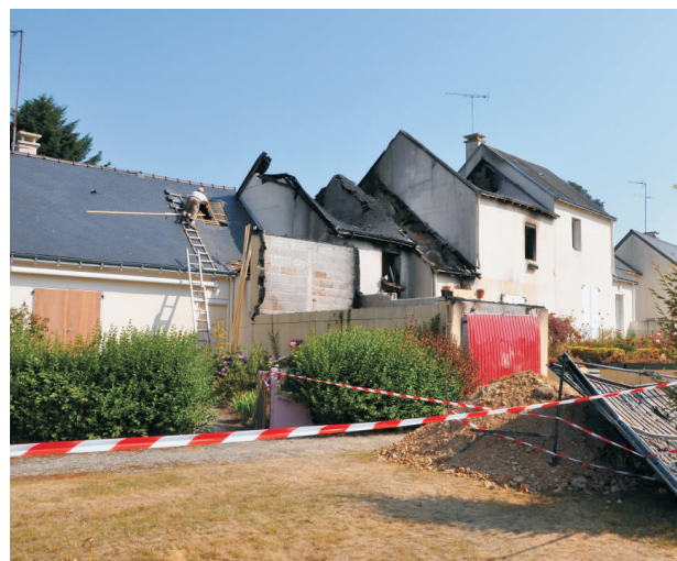
15/07/2013 – explosion à Juvigné (53) travaux de rénovation d'un réseau de distribution
