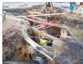
Exemple de réseaux enterrés
