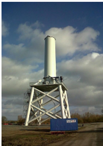
Le prototype en construction (le jacket supportant le premier tronçon de mat)
