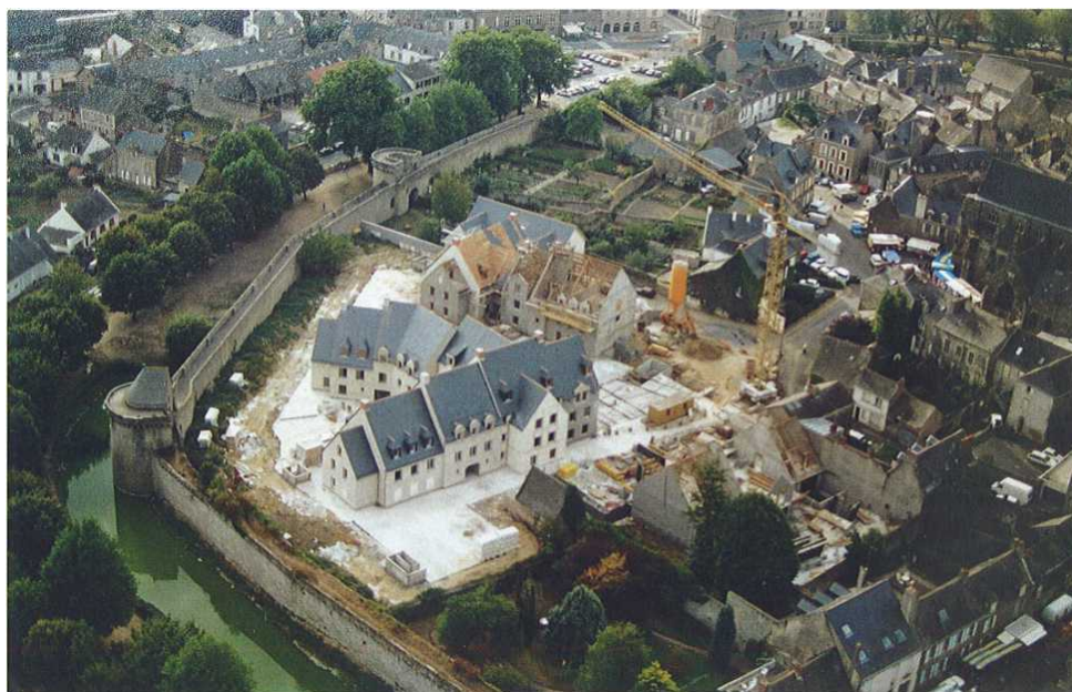
La résidence Balzac en cours de construction à la fin des années 1980
