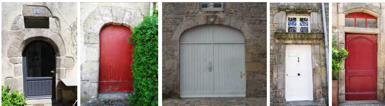
1. Porte cintrée et chanfreinée à imposte, 3 rue de Beau-Soleil. 2. Porte cintrée avec clé et pierres d'imposte saillantes (1697) 3. Ancien porche de l'hôtel des Tréhorets à profil en anse de panier 4. Porte à imposte au 7 rue Sainte-Catherine. 5. Porte à imposte à linteau bombé au 15 rue Saint-Michel.
