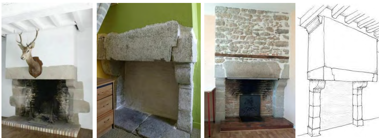
Première moitié du XVII ème siècle : cheminée en rez-de-chaussée du logis au 16 rue de Saillé (bases des piédroits sculptées) ; cheminée nord du deuxième étage du logis au 12 rue de Saillé avec consoles en quart de rond. XVII ème siècle : cheminées à consoles en talon renversé de l'hôtel au 4 place de la Psallette et de l'hôtel de Kerhué (hors PSMV).
