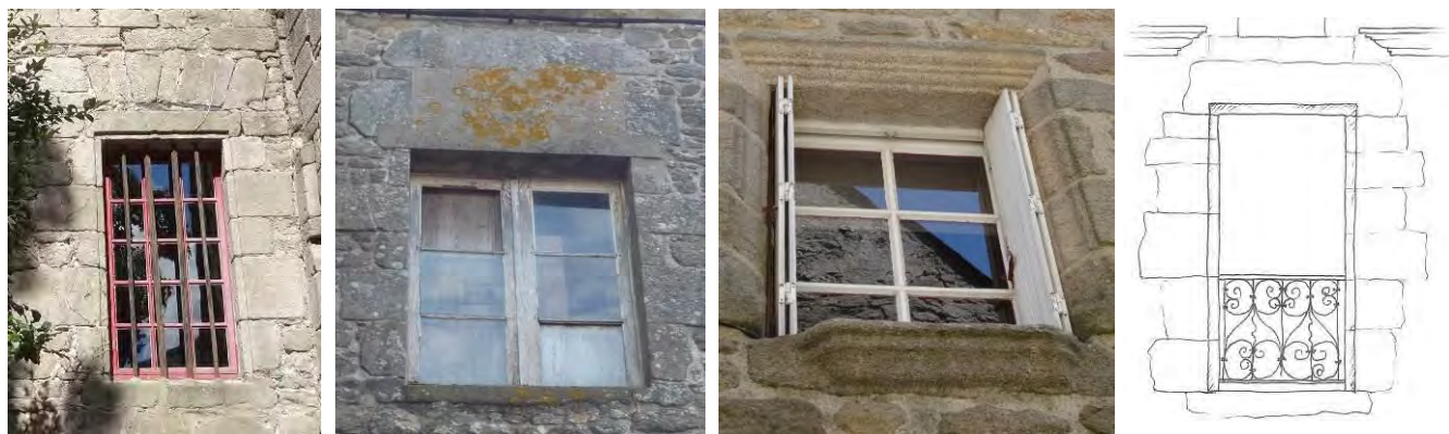
1. Baie à feuillures surmontée d'un arc de décharge. 2. Baie avec appuis remontants. 3. Encadrement et appuis de fenêtre moulurés. 4. Garde-corps en fer plat de l'hôtel des Tréhorets (disparu).
