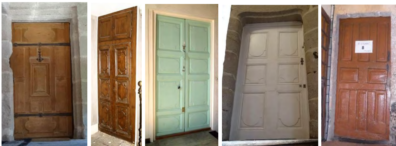
Porte palière d'esprit Renaissance, hôtel de Coux ; porte de placard, hôtel des Tréhorets (avant travaux) ; porte palière de l'hôtel au 4 place de la Psalette ; porte palière de la maison au 15 rue Saint-Michel et du logis au 12 rue de Saillé.
