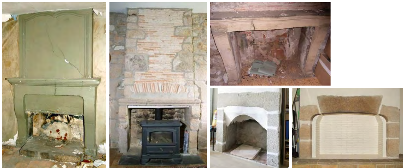
Cheminée à consoles convexes surmontée d'une tablette dans les combles de l'hôtel des Tréhorets, 7 place du Vieux Marché (photo avant travaux) ; cheminée sur consoles en quart de rond et fin linteau mouluré, 6 rue du Tricot ; cheminée sur consoles convexes, 3 rue de Saillé ; cheminées modestes au 9 rue des Capucins et au 21-23 rue Saint-Michel (remaniée ?).
