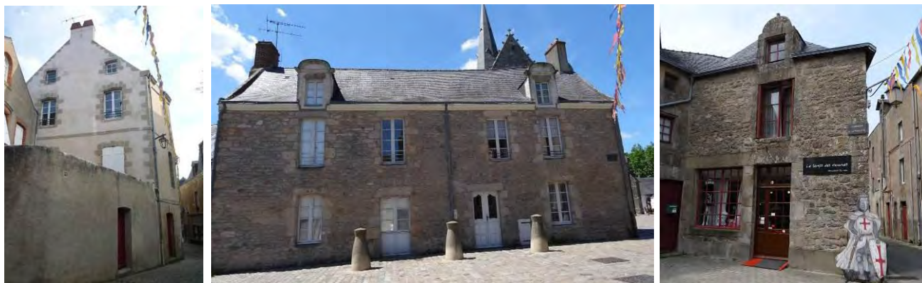
Toitures à forte pente et pignon découvert à crossettes des hôtels Rouaud de la Ville-Martin et des Tréhorets ; Maison d'angle à façade relativement étroite couverte par une toiture à croupe d'origine.
