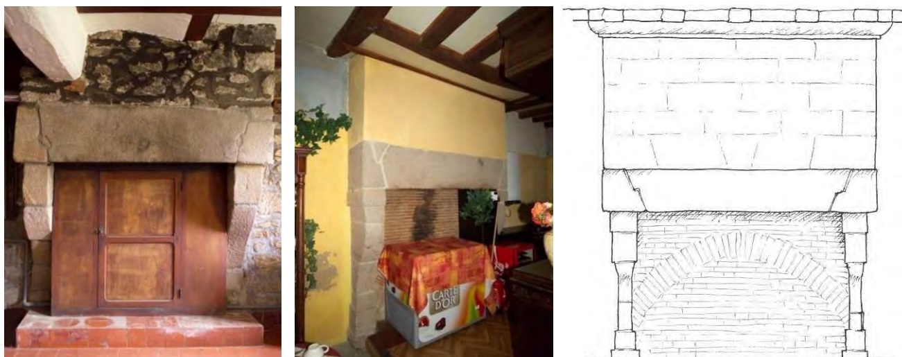
Cheminées sur piédroits à consoles convexes de la maison au 9 rue de Bizienne et du logis au 12 rue de Saillé.
