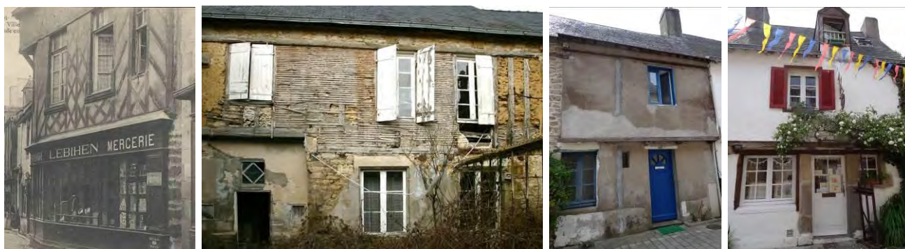
Maison en pan de bois de la rue Saint-Michel datant du XVII e siècle (aujourd'hui disparue), carte postale ancienne, source : AD44, 23 Fi 3371. Façade sur cour d'une aile de l'hôtel des Tréhoret avant restauration, source : Service Régional de l'Inventaire. Maisons en pan de bois sur mur gouttereau avec léger encorbellement, 1-3 rue de la Psallette.
