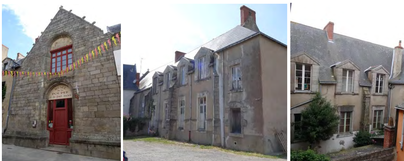
Façade principale rue de Saillé, façades sud et nord.
