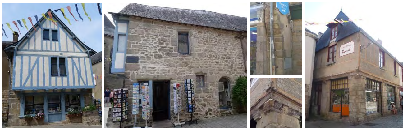
Façade à pignon en pan de bois et mur gouttereau maçonné de la maison du Potier ; détail de mur de refend à encorbellement au 6 rue du Pilon ; maison au 2-4 rue Saint-Michel, détail du pilier d'angle avec consoles en bois moulurées supportant la sablière et façades en pan de bois.
