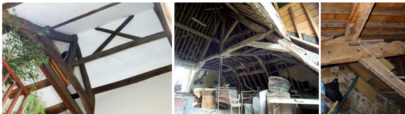
Ferme du XVII ème siècle à aisseliers droits et dispositif en croix de Saint-André, 7 place de la Psalette. Détail de la croupe, hôtel Sécillon-Villeneuve. Détail d'un arbalétrier percé régulièrement, 11 rue du Tricot.
