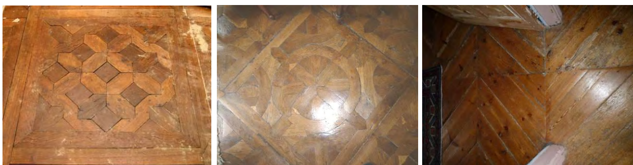
Panneaux type « Versailles », hôtel des Tréhorets (avant travaux) et hôtel de la Gaudinays ; disposition en point de Hongrie, hôtel de la Gaudinays.
