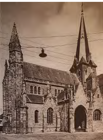
La collégiale avant l'enterrement des réseaux
