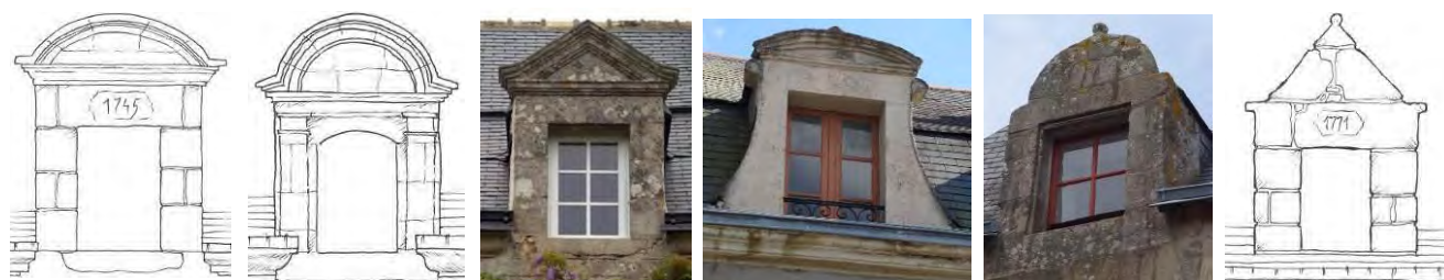
1.2.3. Lucarnes passantes à fronton cintré, à fronton cintré porté par des pilastres et à fronton triangulaire 4. Lucarne à fronton cintré et ailerons. 5. Lucarne passante à pignon galbé. 6. Lucarne « traditionnelle » à pignon avec décor de boule de faîtage et crossettes.
