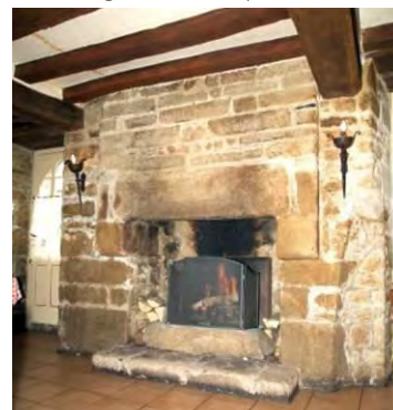
Cheminée monumentale en rez-de-chaussée de l'aile ouest de l'hôtel de Coux, 1 place de la Psallette - 2 rue des Capucins
