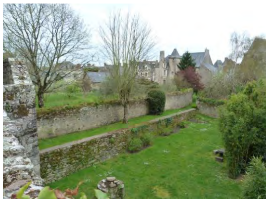
Murs séparatifs servant de soutènement à l'arrière de l'hôtel de la Bouxière.
