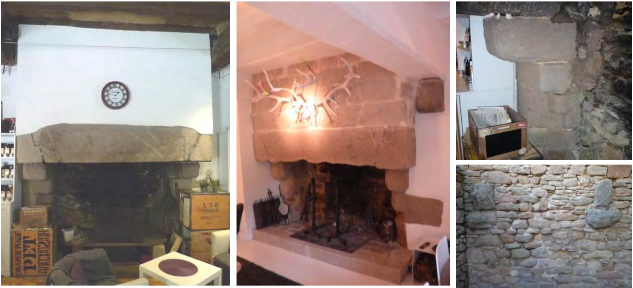
Première moitié du XV ème siècle : cheminées monumentales portées par une paire de corbeaux, 30 rue de Saillé (vue d'ensemble et détail) et 3 rue du Beau Soleil. Consoles encastées dans un mur pignon, ruelle Saint-Michel.
