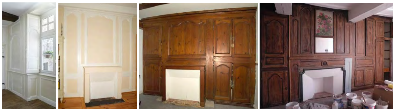
Boiseries, tableaux de fenêtre et volets intérieurs à motifs chantournés, 7 place de la Psallette ; boiseries fin XVIII ème -début XIX ème siècle intégrant des cheminées en bois, 9 rue des Capucins et 3 rue du Beau Soleil.
