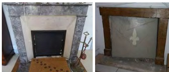
Cheminées ordinaires XIX ème en marbre et en pierre, 7 rue Honoré de Balzac et 2 rue du Pilon
