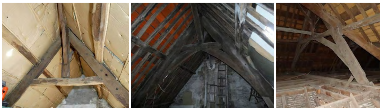
Ferme du XVI ème siècle à faux-entrait, poinçon court et décharges, 6 rue Saint-Michel. Ferme du XVI ème siècle à faux-entrait, poinçon court, aisseliers et jambages courbes, 4 rue du Tricot. Ferme de la chapelle Saint-Jean (entrait bas et faux-plafond du XIX ème siècle).
