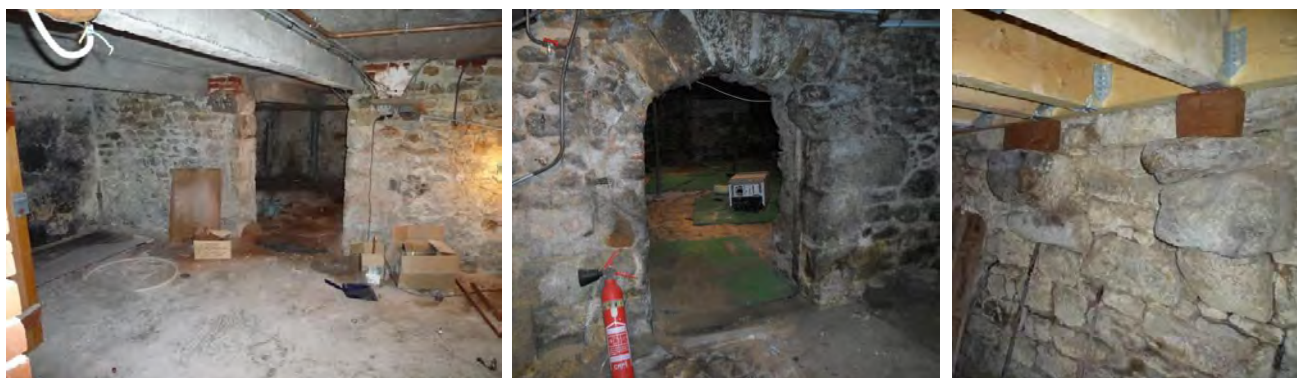
Cave en maçonnerie avec plancher haut en béton dans un immeuble de la fin du XIX e siècle. Porte ancienne (XVII e siècle ?) dans la cave d'un immeuble reconstruit au XIX e siècle. Corbeaux en pierre supportant un plancher bois récent.
