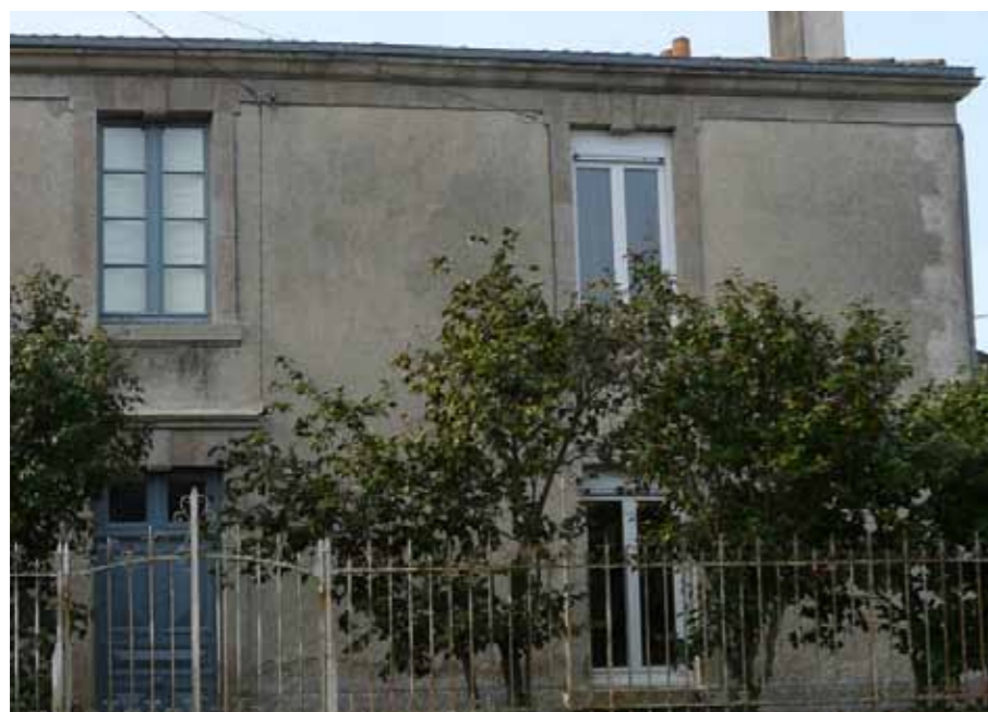
Façades enduites, encadrements et chaînage en granit
