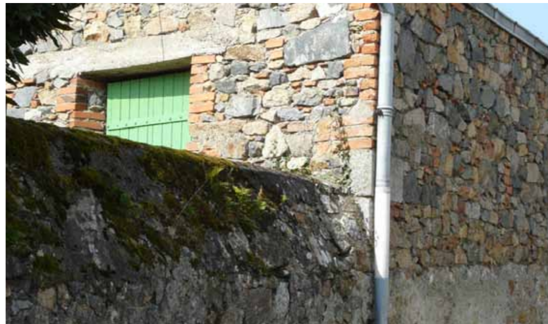
Mur de clôture et dépendance sommairement enduits
