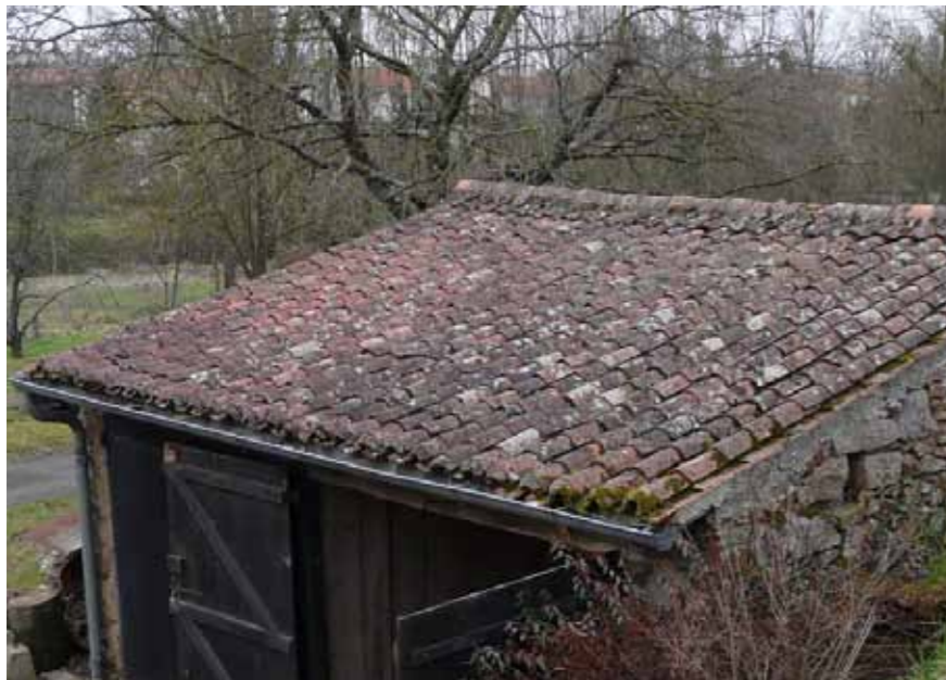
Couverture en tuiles tiges de botte
