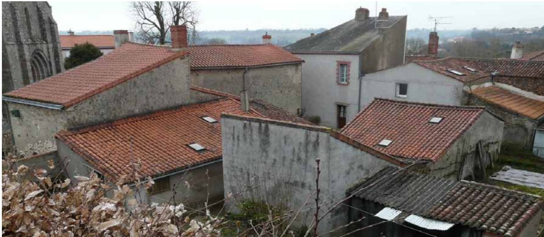
Les toitures du bourg de Montfaucon vues depuis la motte féodale
