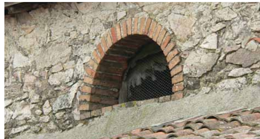
Encadrement en brique sur une grange
