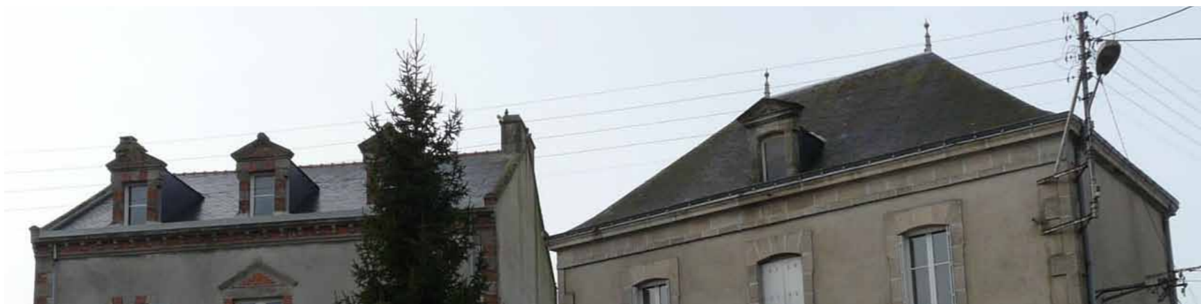
Couvertures en ardoises sur demeures bourgeoises, avec corniches et lucarnes en pierres
