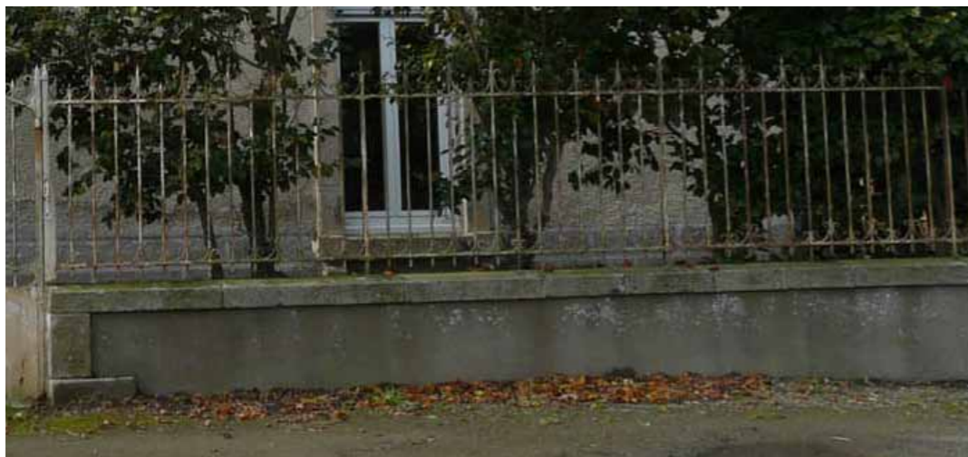
Murs bahuts surmontés d'une grille en fer forgée, avec banquette en granit
