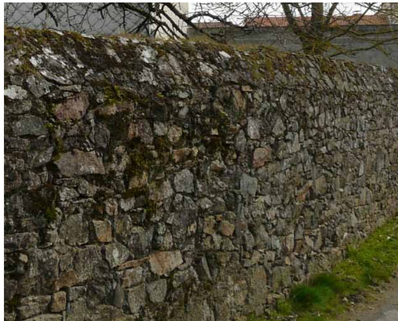
Murs en moellons terminé par un chanfrein
