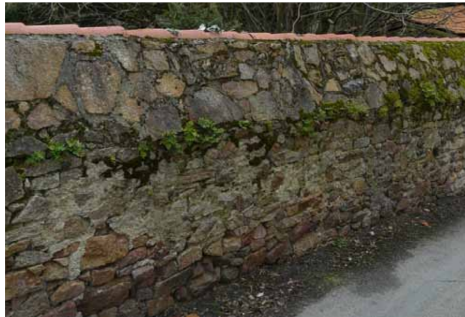
Murs en moellons terminé par un chanfrein couvert en tuiles
