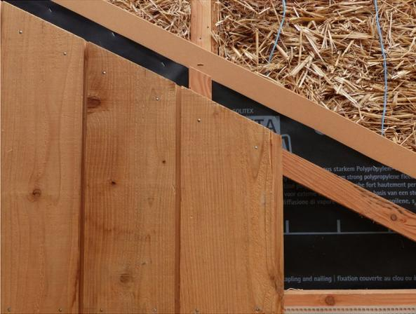
***Vue extérieure d'un caisson : bardage, liteaunage, grilles de protection, pare-pluie souple, contreventement\*, ossature Douglas et isolant paille.***
