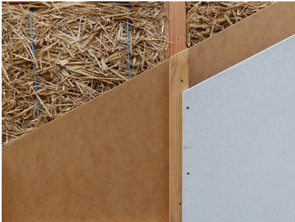
***Vue intérieure d'un caisson : plâtrerie, vide technique, étanchéité par membrane, contreventement\*, ossature Douglas et isolant paille.***
