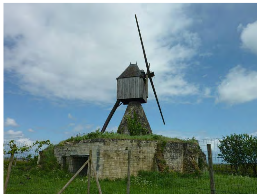
Le moulin de la tranchée (ISMH, 1978) construit vers 1750-1780 et restaurée en 1984. La cabine ou hucherolle, pivote pour être exposée au vent, elle est juchée sur un massereau (cône maçonné qui abrite l'armature en fer du gros fer).
