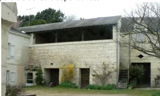
Bâtiment agricole dans le bourg
