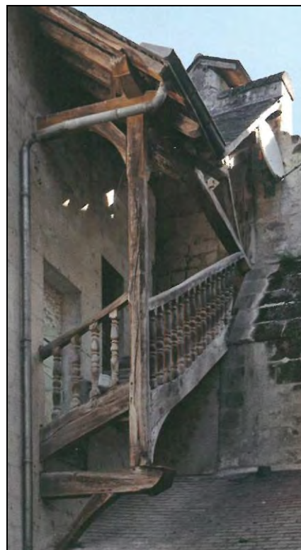
Escalier extérieur – basse Rue
