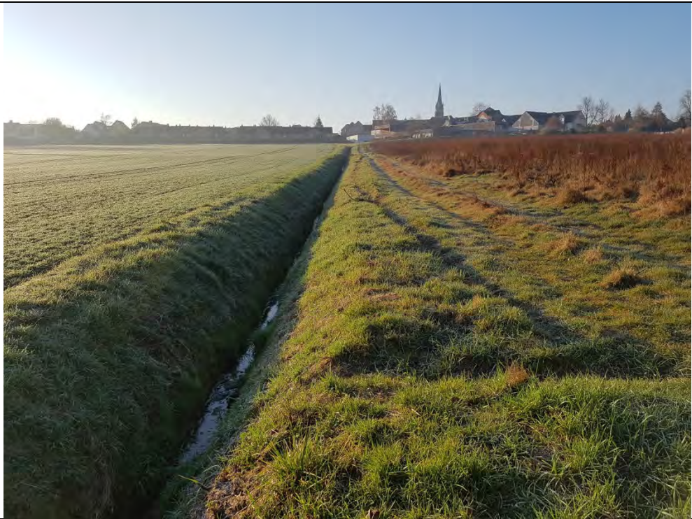
Photographie n°07 : Vue du fossé, dans le sens nord vers sud (i.e. aval vers amont), depuis la pointe nord-est de la parcelle ZA26 : tracé rectiligne, profil en travers triangulaire (source : ACE 3 , 28/02/2019).
