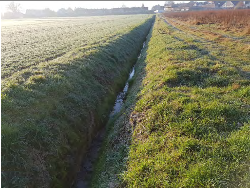
Photographie n°08 : Vue zoomée du fossé, dans le sens nord vers sud (i.e. aval vers amont), depuis la pointe nord-est de la parcelle ZA26 : largeur au plafond limitée à 0.20 m environ, berges quasiment verticales (source : ACE 3 , 28/02/2019).
