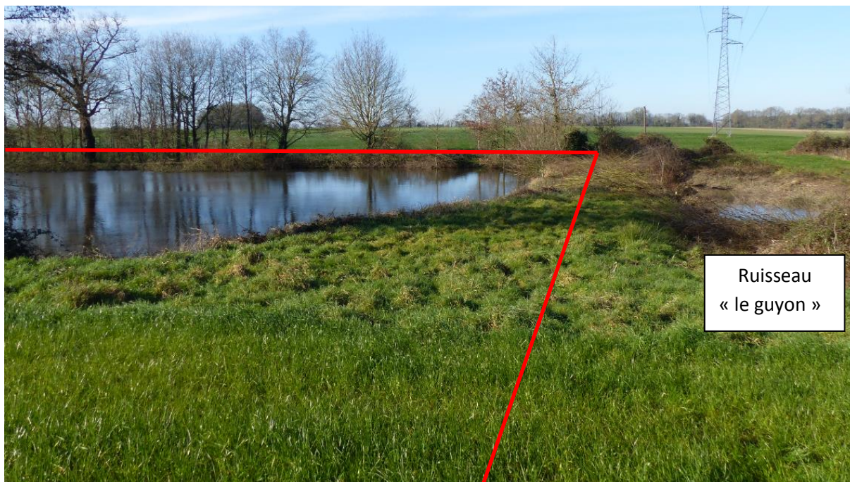
Photo 3 : prise au niveau de la digue amont de la réserve à créer. Cette digue (en rouge) sera rehaussée d'environ 3m, tout comme la digue longeant le guyon de l'autre côté. On aperçoit le guyon longeant la réserve par la droite (22/01/2020)
